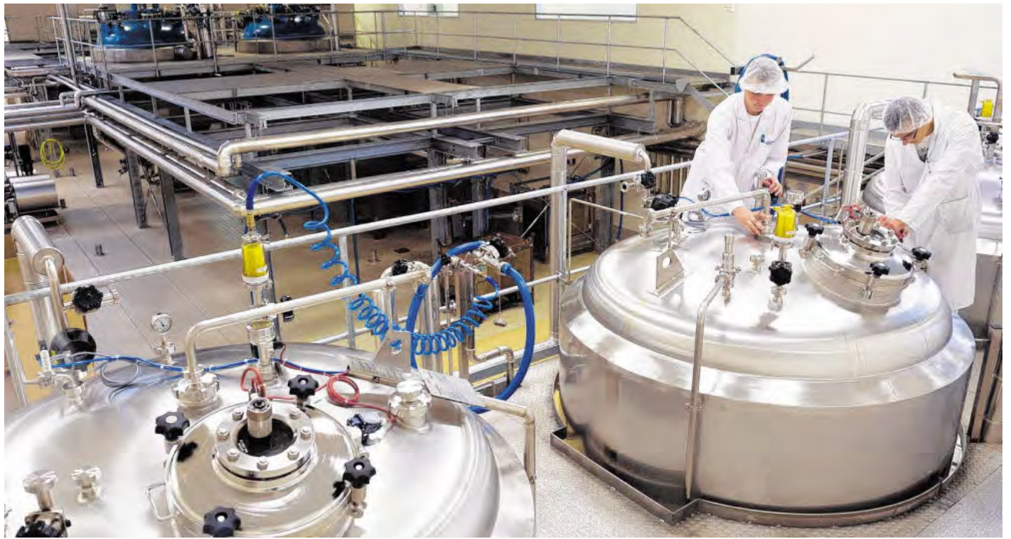
Für die HES-Synthese wurde das neue Produktionsgebäude errichtet. Im Hintergrund ist der Platz zu sehen, der schon für die nächste Erweiterung einkalkuliert wurde.
